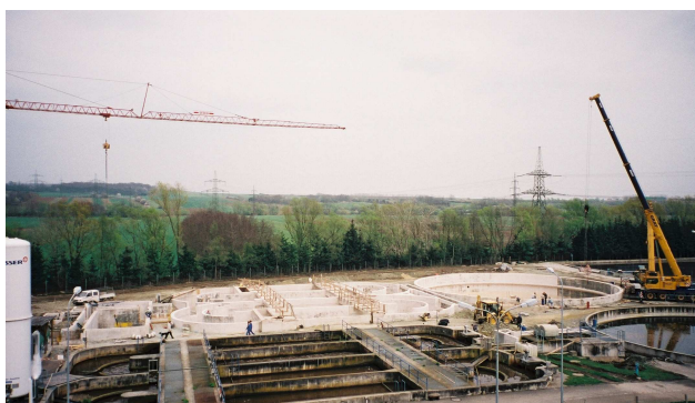
7. ábra: Oberwarti derítő – háttérben a Slagstar® betonból épült új részzel
