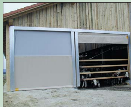
Etetőasztal és trágyázófolyósó kapuja, motoros működtetéssel és távirányítóval
