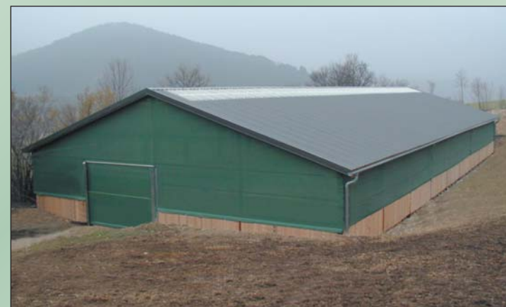
Szélfogó panelekből készült oromfalak és hosszanti határoló szerkezetek, felhegesztett hevederekkel és racsnis feszítőkkel.
