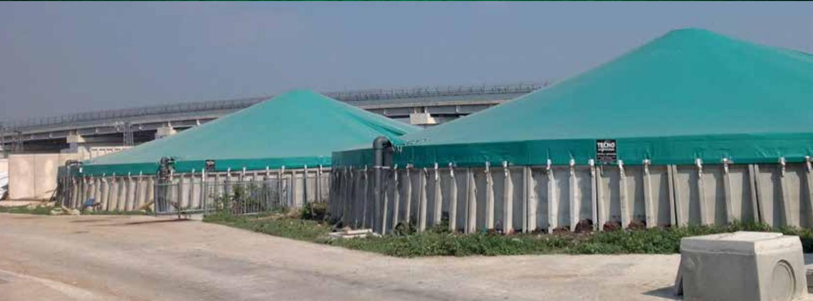
Realizziamo, a misura, coperture per vasche circolari di stoccaggio reflui animali / industriali a telo singolo e coperture per impianti biogas con membrana doppia.
