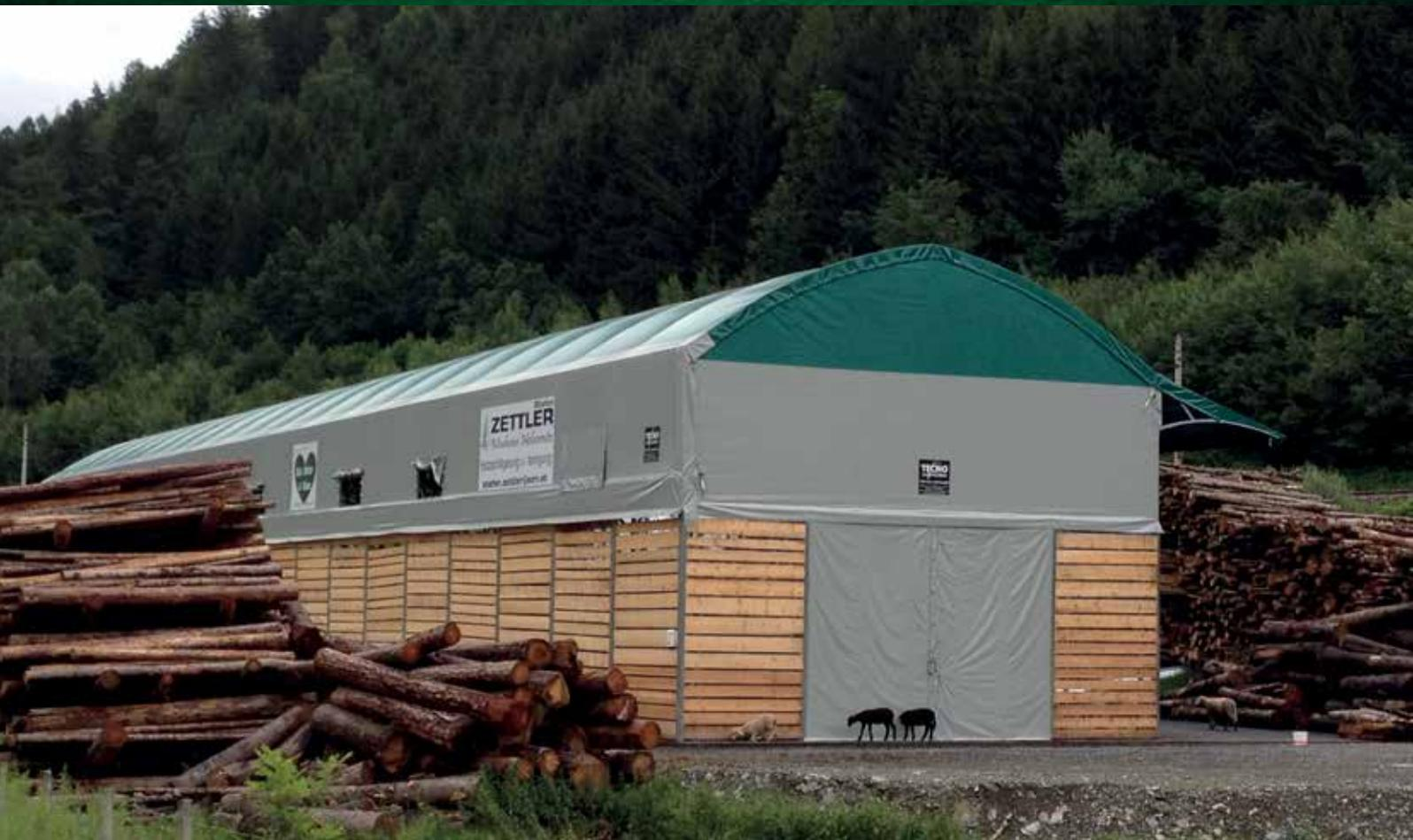
Realizziamo anche strutture speciali su misura per la copertura di materiali particolari e/o il contenimento di polveri, fumi, odori sgradevoli. Il nostro ufficio tecnico valuterà la miglior soluzione costruttiva di ogni singolo progetto e seguirà, passo dopo passo, l'evoluzione di ogni fase fino al compimento dell'opera. Ancoraggio al terreno senza fondazioni in cemento o, eventualmente, con piastre tassellate su platea.
