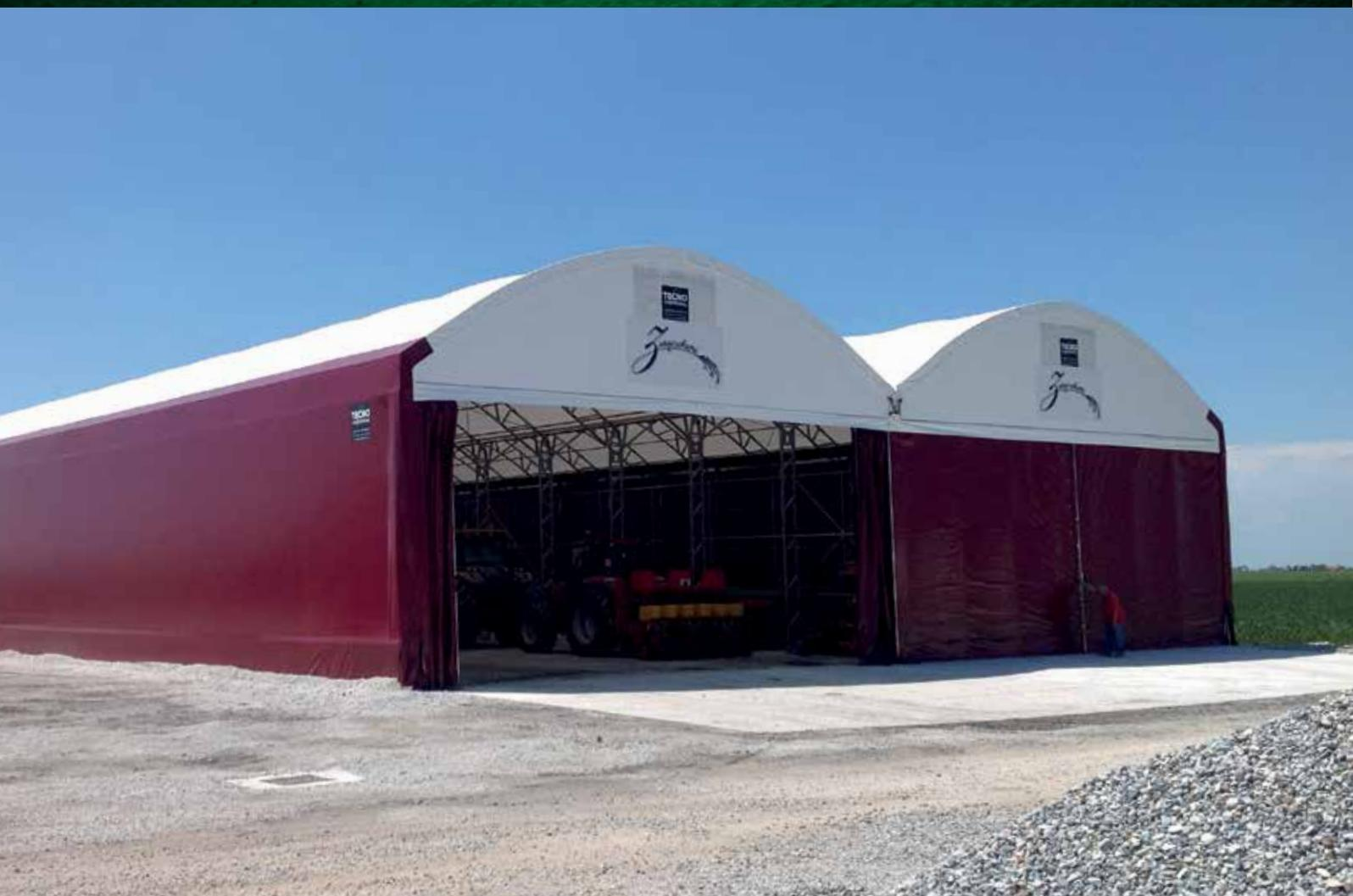
Tunnel di copertura affiancati, ideali per: ricovero foraggio, stoccaggio merci, ricovero macchine e attrezzi agricoli, protezione animali, copertura concimaie e/o depositi liquami. Struttura in acciaio zincato a caldo "sendzimir" o zincato a caldo per immersione. Rivestimento in telo PVC tramato ad alta resistenza ed ignifugo cl.2. Ancoraggio al terreno senza fondazioni in cemento o, eventualmente, con piastre tassellate su platea.
