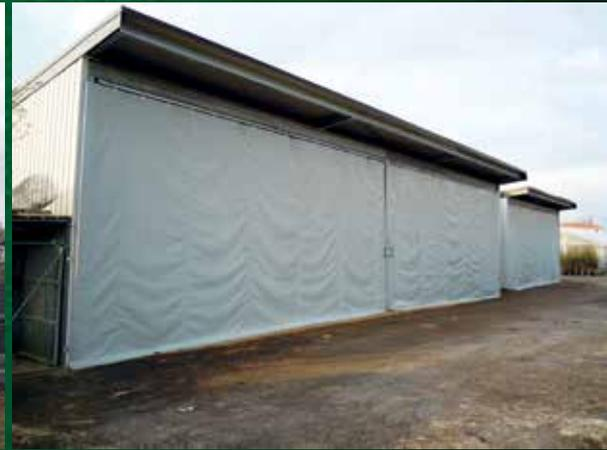
Pareti realizzate in tessuto poliestere ad alta resistenza, bispalmato in PVC, ignifugato classe 2, provvisto di cinghie termosaldate per il tensionamento fisso oppure con accessori per la movimentazione laterale. Possibilità di inserimento oblò trasparenti.
