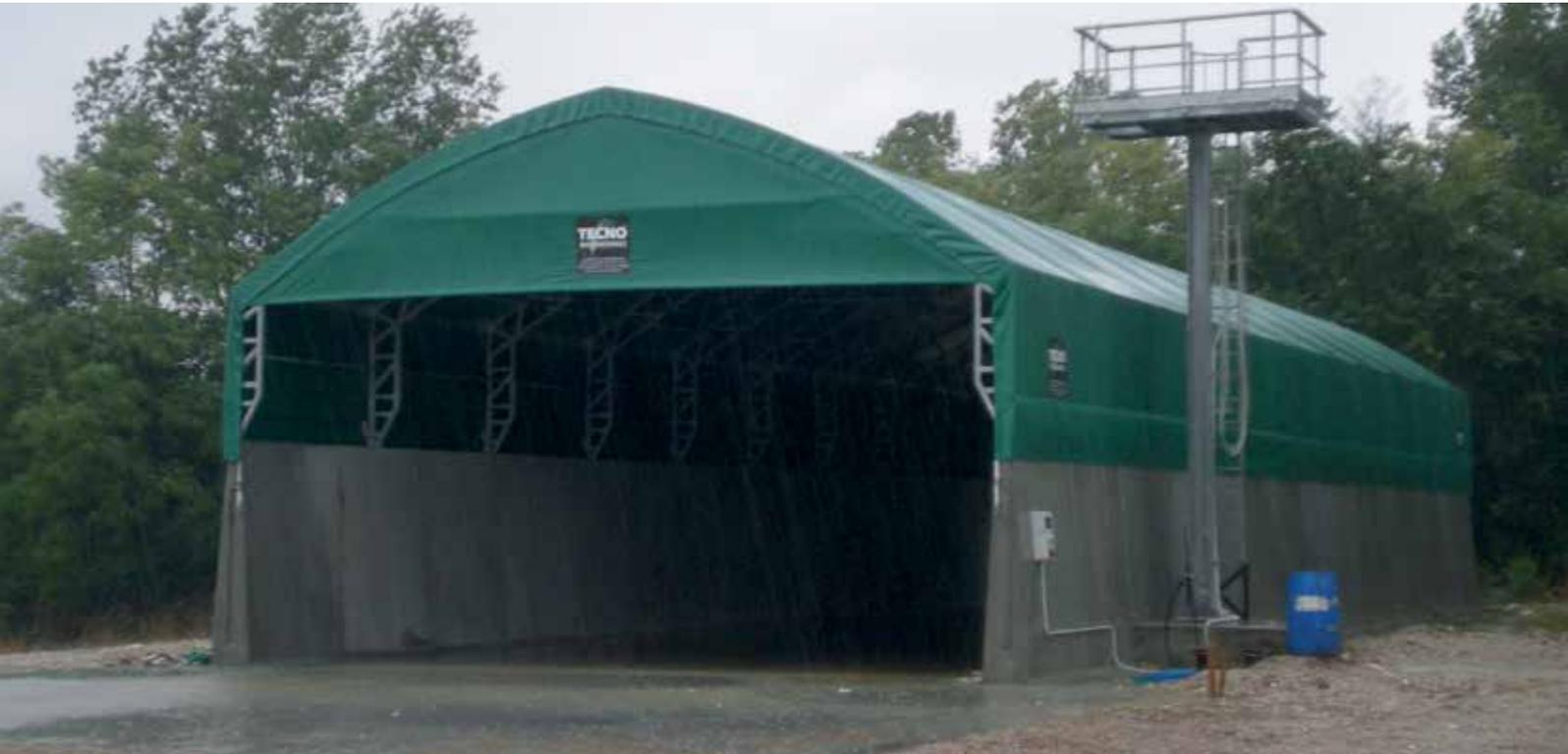
La copri trincea scorrevole e fissa riduce notevolmente le fermentazioni secondarie dell'insilato. Limita il sovrariscaldamento dovuto all'irraggiamento solare e mantiene stabile il grado di umidità, proteggendo dalla pioggia l'area di prelevamento. Un'importante barriera che riduce il nutrimento dei volatili (impoverendo così il prodotto) ed evita tossicità e contagi causati dai loro escrementi.
