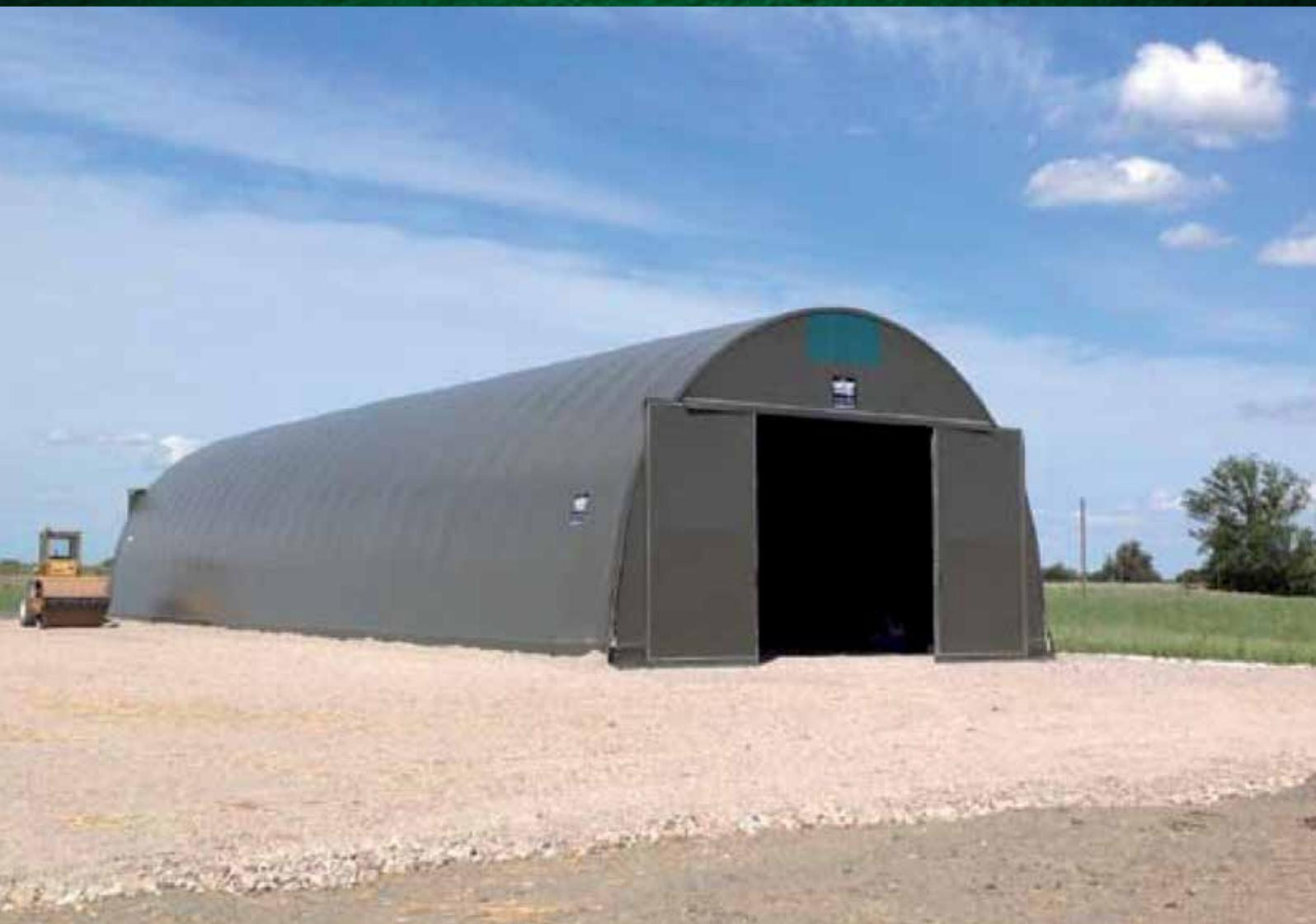
In agricoltura, nelle zone con vento e neve non esasperati, i nostri tunnel ad arco singolo sono la copertura ideale per realizzare fienili per foraggio, protezione animali dalle intemperie, ricovero attrezzi agricoli, impianti di orticoltura e floricoltura, copertura concimaie e/o deposito liquami. Ancoraggio al terreno senza fondazioni in cemento o, eventualmente, con piastre tassellate su platea.
